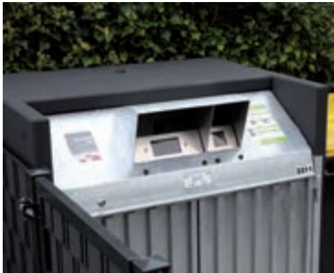
Die neue elektronische Müllschleuse, die am Hochhaus Zeppelinstraße installiert wurde
