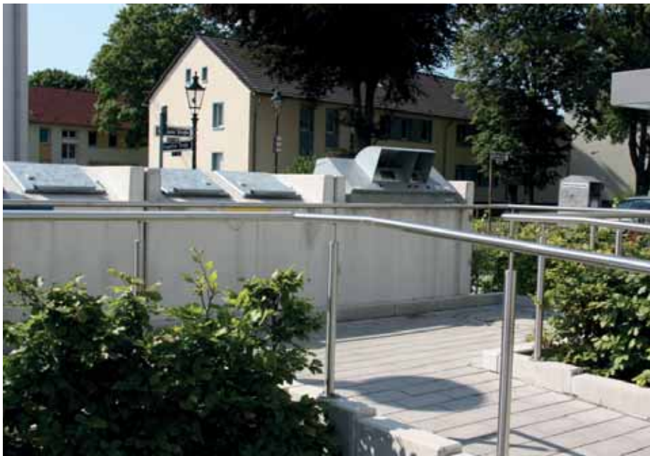
Auch Müllplätze müssen für ältere oder körperlich eingeschränkte Menschen gut zugänglich sein. Müllplatz der neugebauten Anlage in der Breslauer Straße
